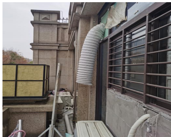
图 6 总排气口朝向西藏路
